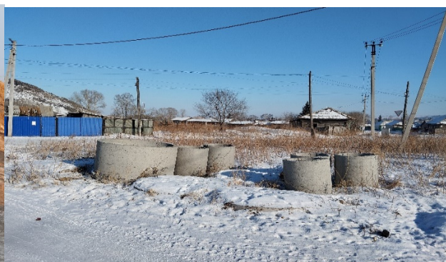
Фото 8. Строительство водопровода с. Боград
