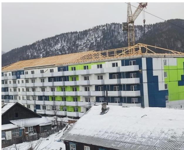
Строительство МКД для переселения в г. Абаза (февраль 2024 г.)
