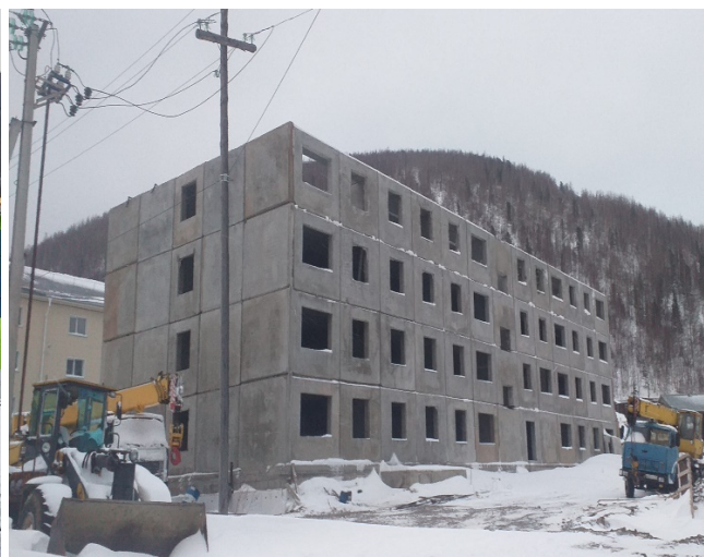
Строительство МКД для переселения в п. Приисковый (февраль 2024 г.)
