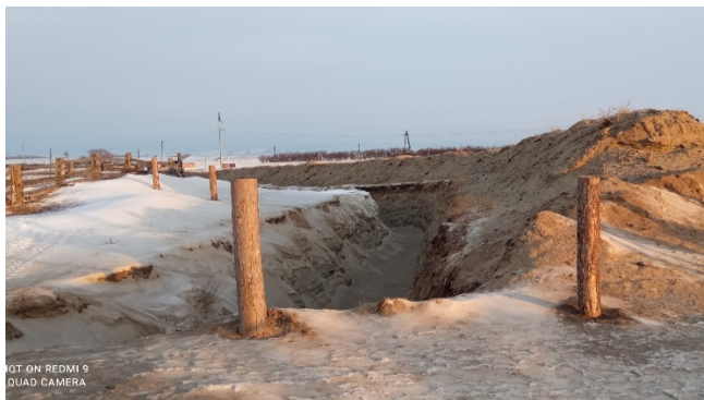
Фото 7. Строительство водопровода с. Бондарево
