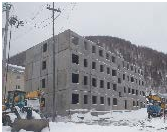
Строительство МКД для переселения в п. Приисковий (февраль 2024 г.)
