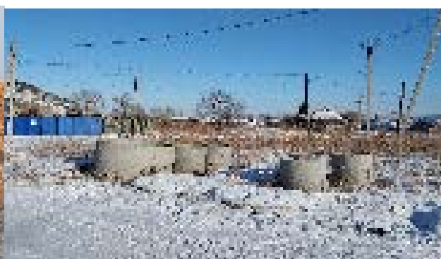
Фото 8. Строительство водопровода с. Боград
