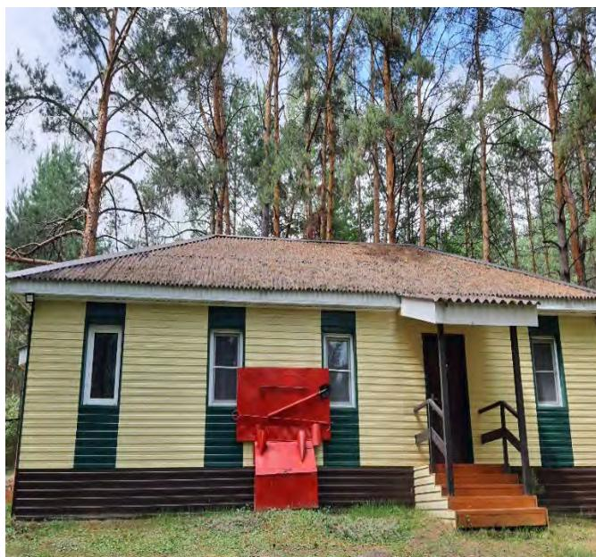
обшивка стен металлосайдингом с устройством металлического каркаса
