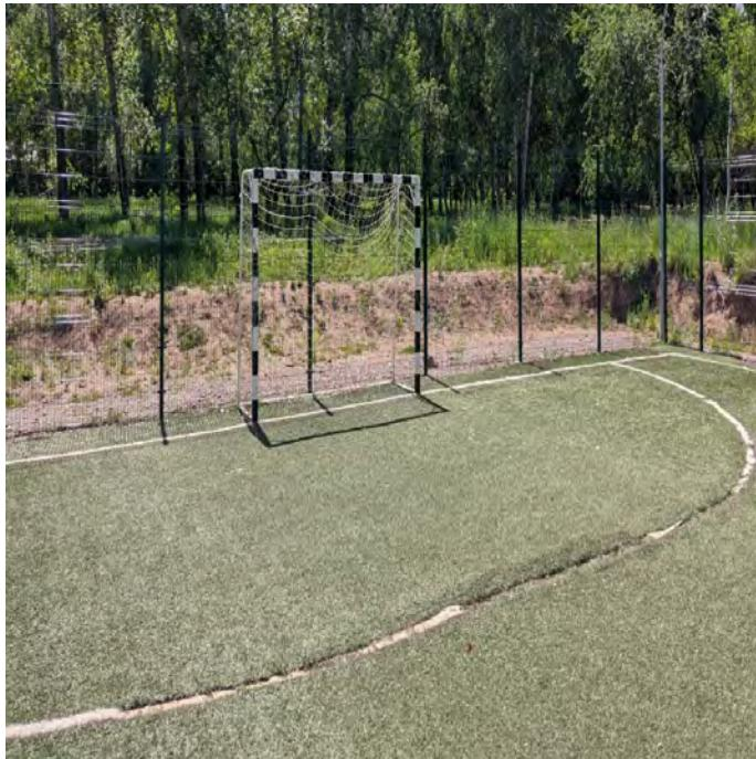
частичная утрата разметки и следы отклеивания подложки для стыков
